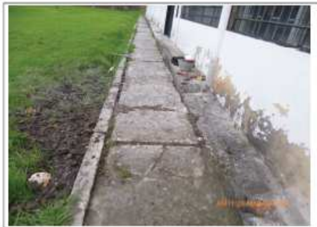
Foto 3 : ARREGLO DESPUES DE HABER HECHO APIQUE EN BLOQUE 4
