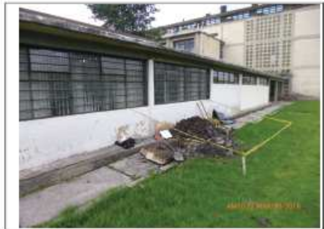
LOCALIZACION DODE SE REALIZO LA EXPLORACION DE CIMENTACION
