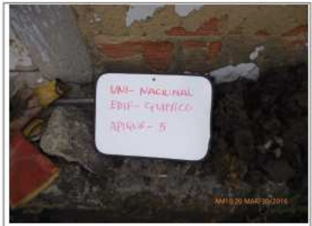
Foto 2: LA MAMPOSTERIA EN EL BLOQUE 4 ES LADRILLO HUECO
