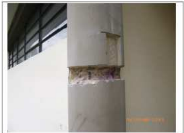
Foto 4 : TIPOLOGIA ESTRUCTURA BLOQUE 4, SISTEMA DE PORTICOS.
